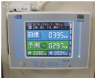
① デマンド監視装置により使用量を予測しながらピーク電力を抑制
